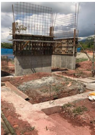
Estructura pantallas primer nivel terminadas
