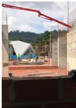
Estructura pantallas primer nivel terminadas
