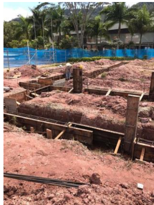
Estructura pantallas primer nivel terminadas
