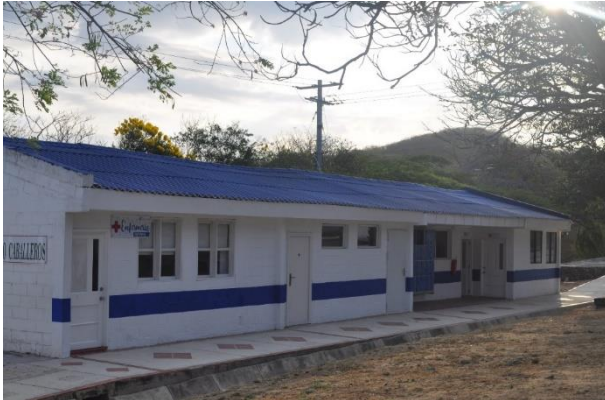
PINTURA TECHOS Y CAMINOS PEATONALES
