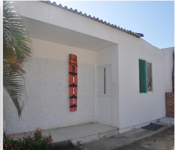
CERRAMIENTO DE COCINA
