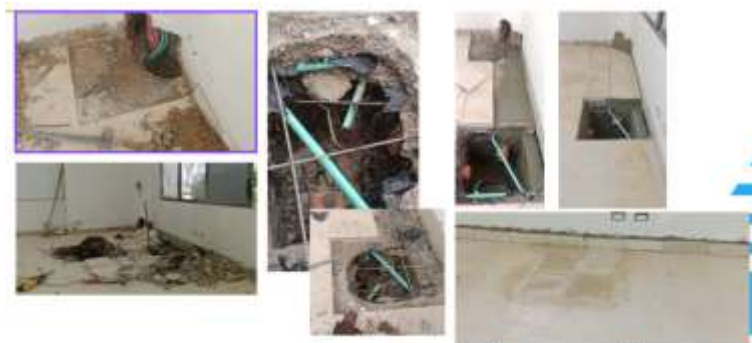
Descubrimiento de registro de desagüe de aguas lluvias en salón de 12 por filtraciones en el piso
